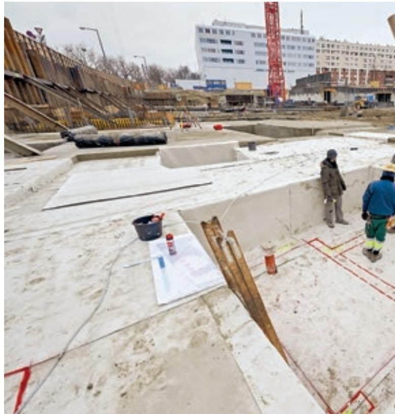
■ Montage der Bentonitbahn auf Bohrpfähle
