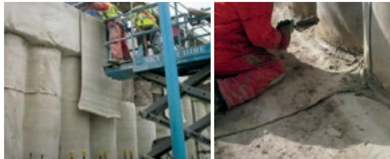
■ Abdichten eines Geothermieverteilers
