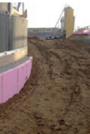
■ Schutz der Abdichtung mittels Perimeterdämmung
