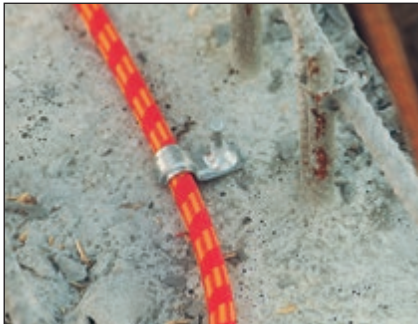
Befestigung mit Metallschellen zum Schießen oder Nageln. Abstand max. 15 cm
