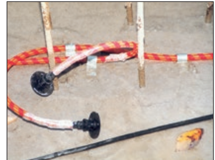
Schlauch fertig verlegt. Die Packer werden an die Schalung genagelt
