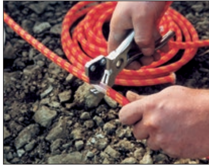
Schlauch zum Ablängen mit Filamentband abkleben (Verpresskreis max. 8 m)
