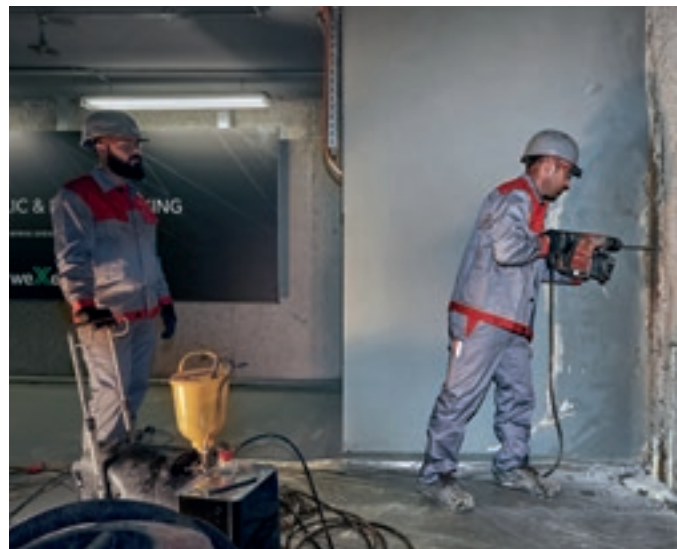
■ Verpressen von Schlitzwandfugen
