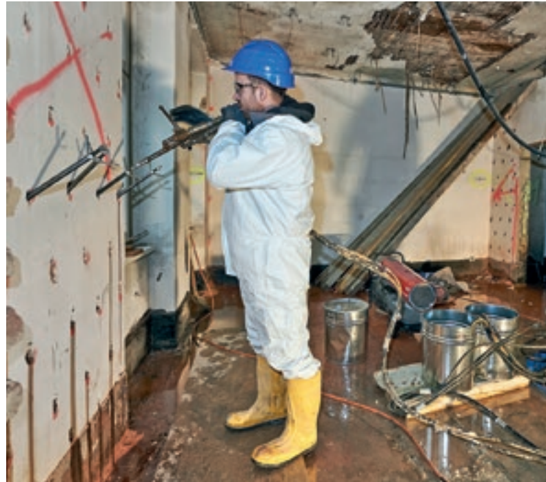
■ Verfestigen der Mörtelschicht mittels niedrigviskosen Polyurethanharz
