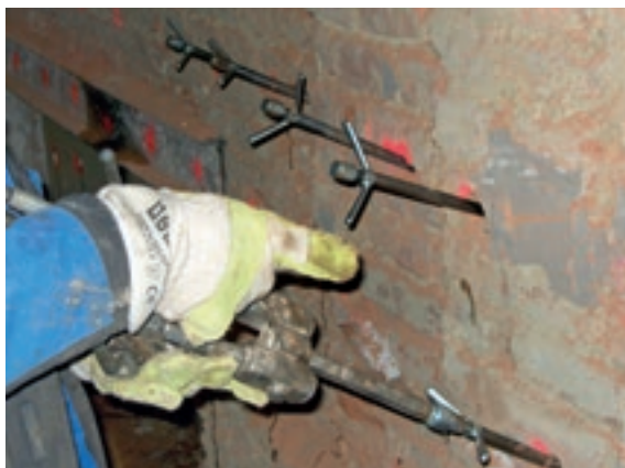
Setzen von Stahlpackern mit Schnellspanknebel
