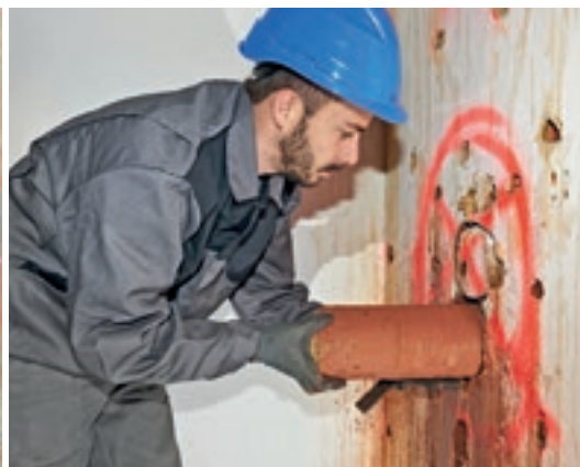
Bohrkernentnahme nach der Verfestigung zwecks Überprüfung der Druckfestigkeit des Mauerwerks
