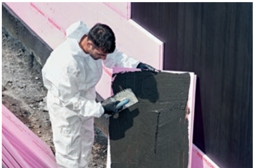
Schutz der fertigen Spritzisolierung (mittels Perimeterdämmung) vor mechanischer Beschädigung, Wärmedämmung
