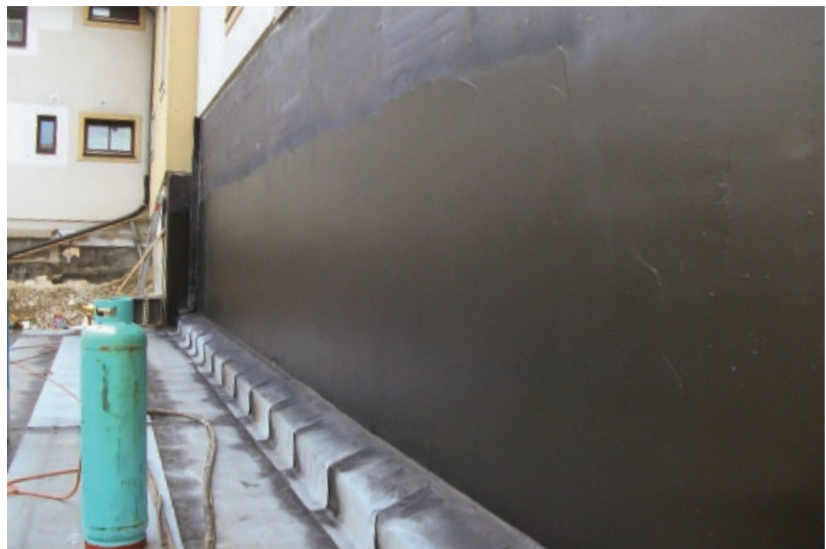
Übergang einer 2-lagigen Polymerbitumenbahn (horizontal) mit der Spritzisolierung (vertikal)
