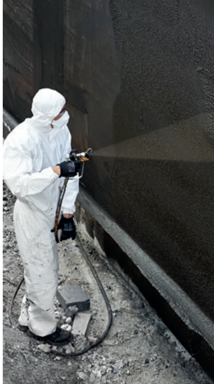
■ Aufbringen der Bitumendickbeschichtung
