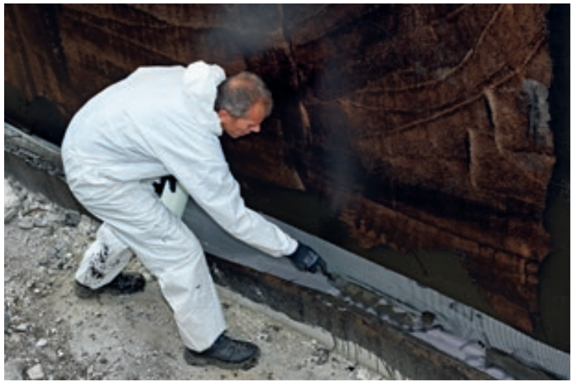
Einarbeiten einer Gewebeeinlage im Bereich der Hohlkehle
