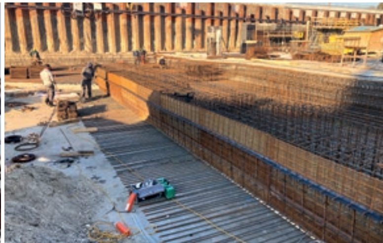
■ Montage von Streckmetall-Abschalelementen inklusive Arbeitsfugenband
