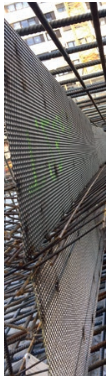
■ Einziehen des Arbeitsfugenband
