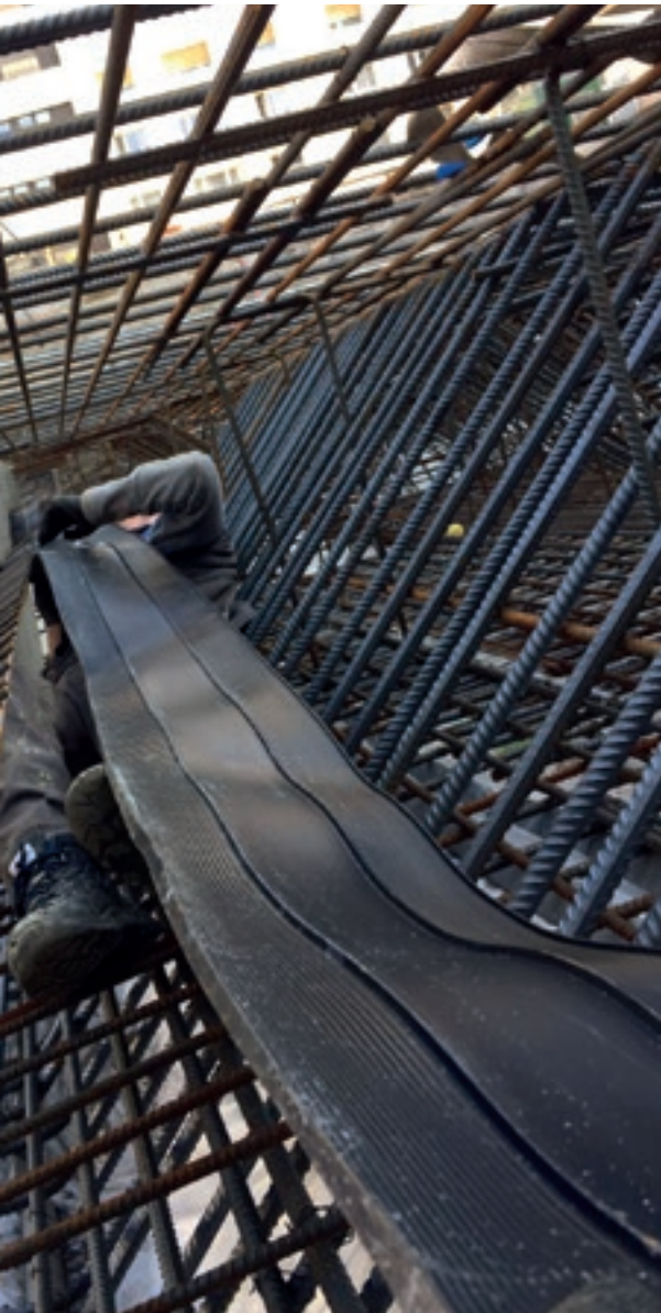
des in die Fugenbandklemme (15° Neigung)
