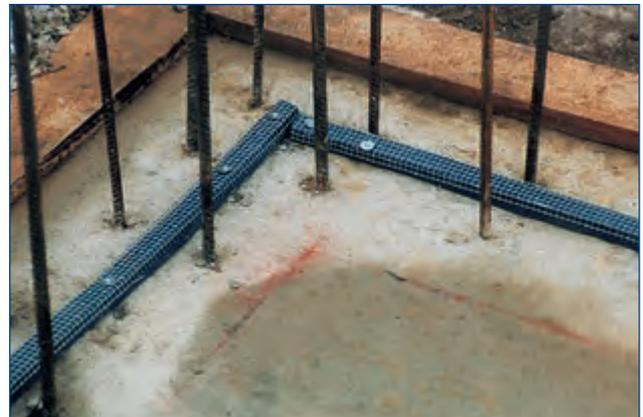
Verlegung mit Befestigungsgitter und Nägel
