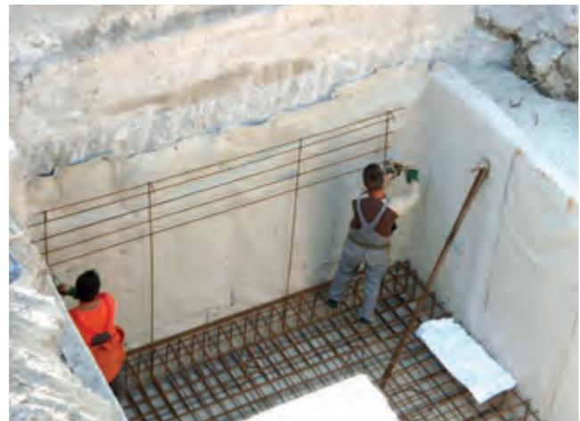
Der Begriff „**Braune Wanne**“ leitet sich von der Braunfärbung der verwendeten Bentonite ab. Dieses Abdichtungs-system findet seine Anwendung bei aufstauendem Sicker- bzw. drückendem Grundwasser. Dank der hervorragenden Quelleigenschaften der bentonit-impregnierten Vliesstoffoberseite, welche üblicherweise dem Bauwerk zugewandt ist, ist der Natriumbentonit eine optimale und aktive Abdichtung. Die gelartige Substanz versiegelt selbstständig die
