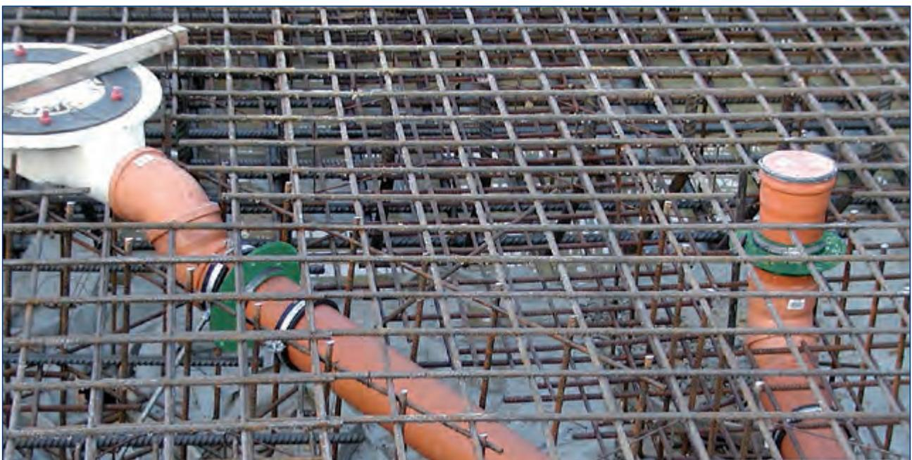
Hier sieht man den RONDO, kurz vor der Betonage. Die Abflussrohre werden sicher und dauerhaft gegen aufsteigende Feuchtigkeit abgedichtet.
