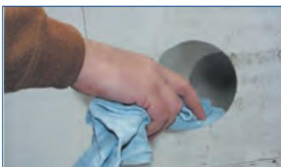
Entstauben der Kernbohrung
