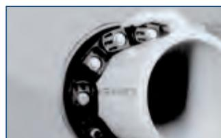
MASTER-SEAL in den Ringspalt einschieben. Nacheinander jede Schraube mit einer Umdrehung anziehen und dies im Kreis herum so lange wiederholen, bis alle Module gleichmäßig fest sind.
