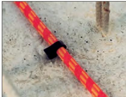
Befestigung mit Kunststoffclips, die vorher in den Frischbeton gesetzt wurden, oder ins Bohrloch Ø 8 mm eingeschlagen werden. Abstand 15 cm
